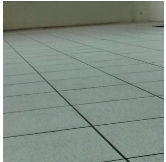
El piso falso con alma de concreto ligero debe ser colocado con los accesorios necesarios para su correcta instalación, los cuales son el pedestal de aluminio plano, el travesaño galvanizado tubular y su tornillería, que en conjunto forman una estructura totalmente estable, segura y confiable, que cubre alturas desde 15 cms. hasta 1.10 mts. de altura.
